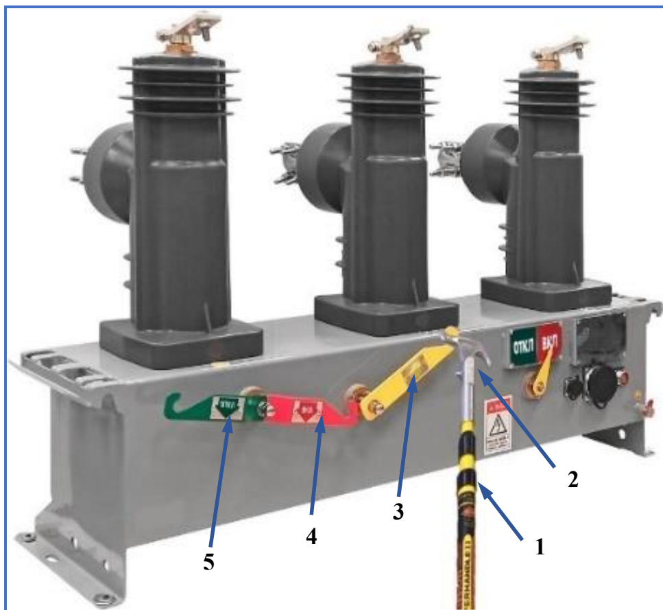
Рисунок 22 – Органы механического (ручного) управления реклоузером
